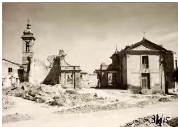
Le distruzioni belliche dopo il 29 gennaio 1944
