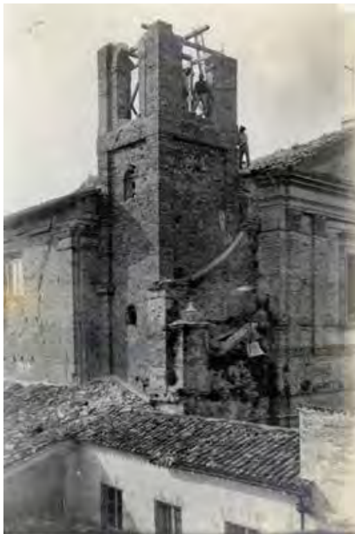
Demolizione del campanile della chiesa dei Teatini danneggiato dal sisma del 1916
