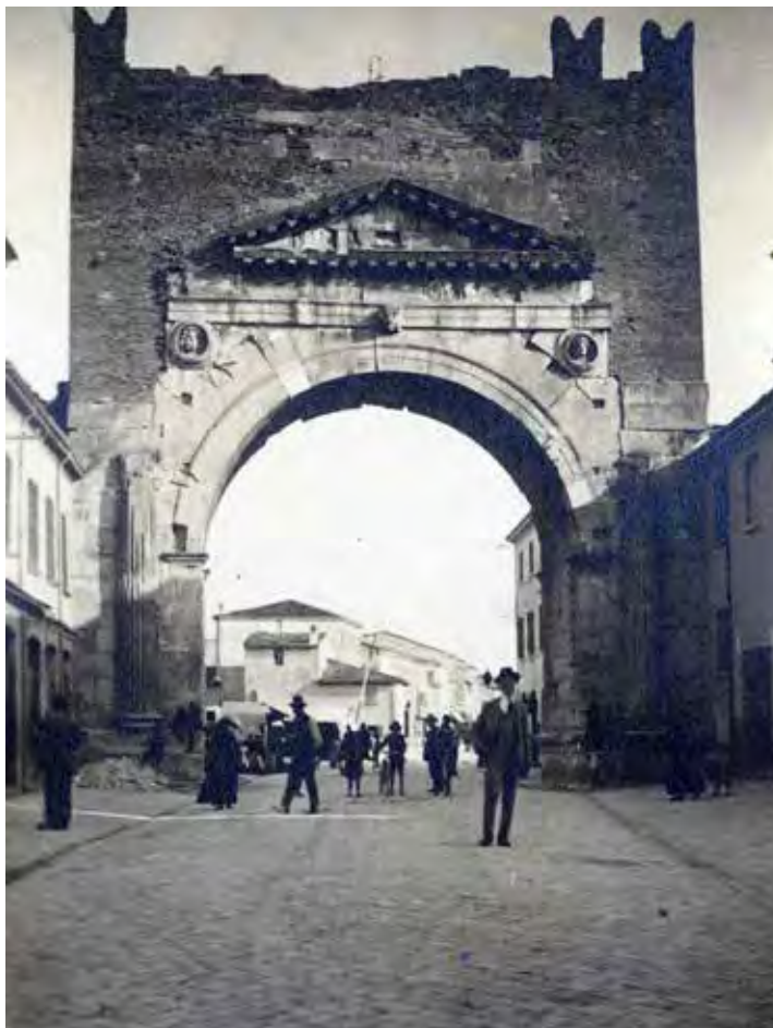
L'Arco d'Augusto danneggiato (terremoto del 1916)
