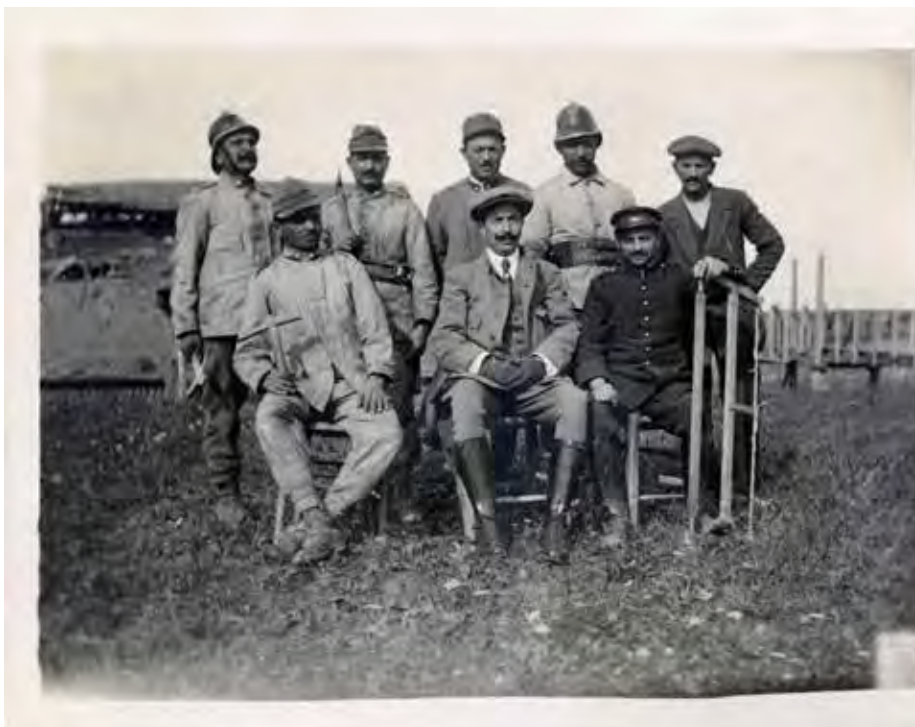
Il Comando dei Pompieri di Rimini (terremoto del 1916)
