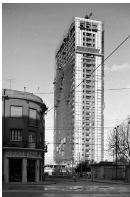
Il grattacielo di Rimini in costruzione (1959)
