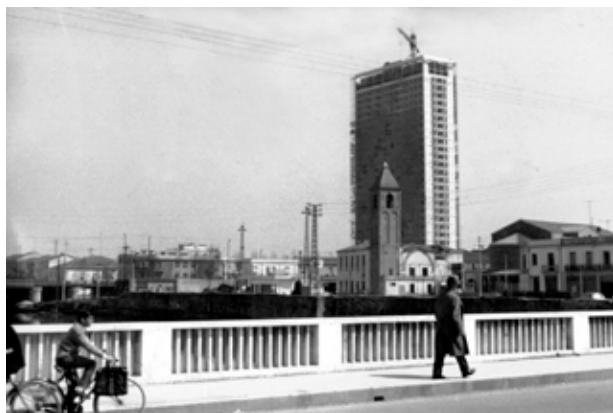
Il grattacielo in costruzione visto dal ponte dei Mille (1959)
